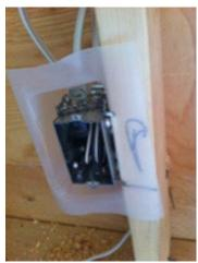
Figure 4—Vapour barrier example
